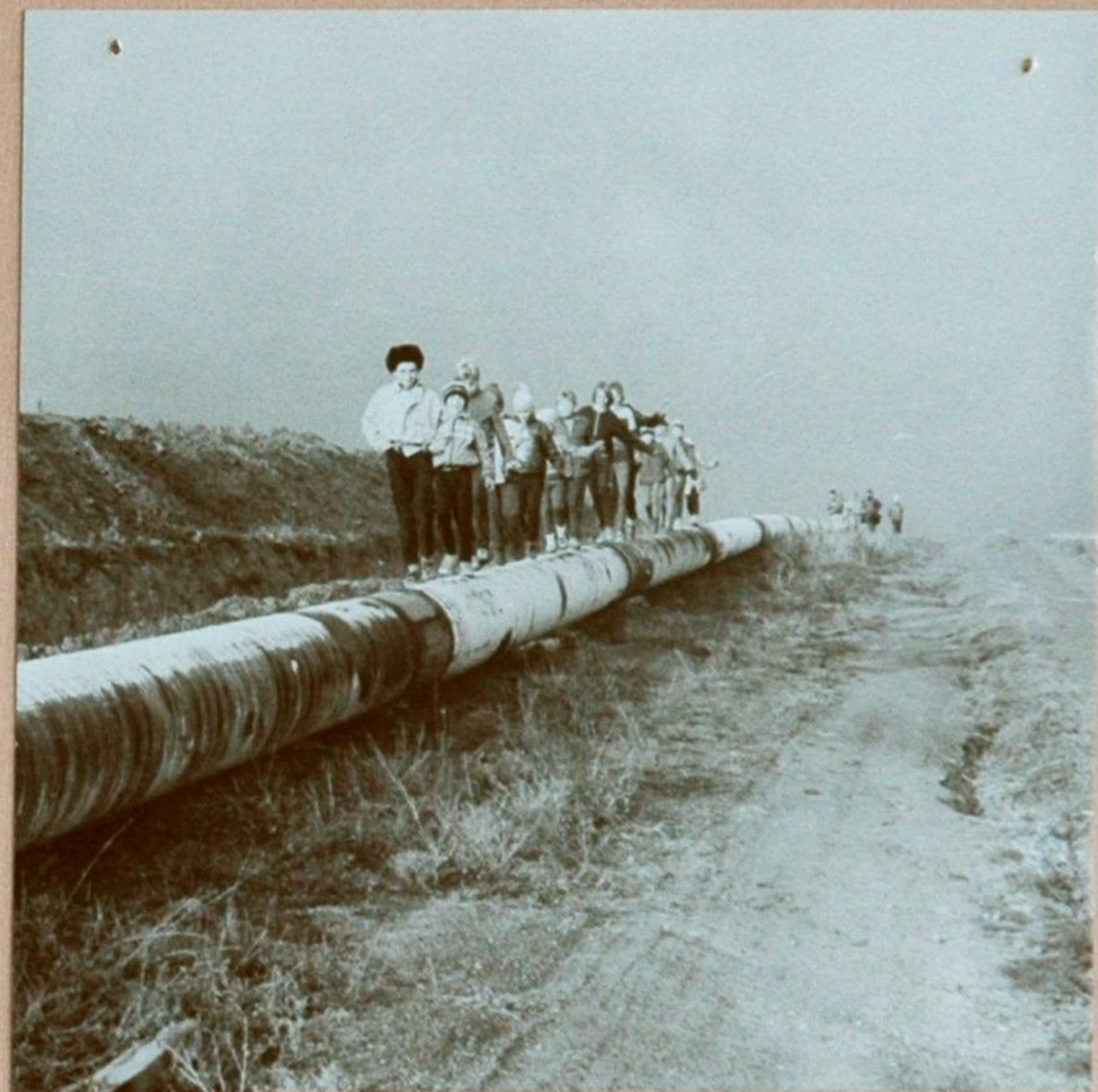
Přivaděč vody do vodojemu na Cyrilově.
