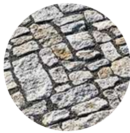
ŽULOVÁ DLAŽBA SE ŠÍROKÝMI SPÁRAMI
