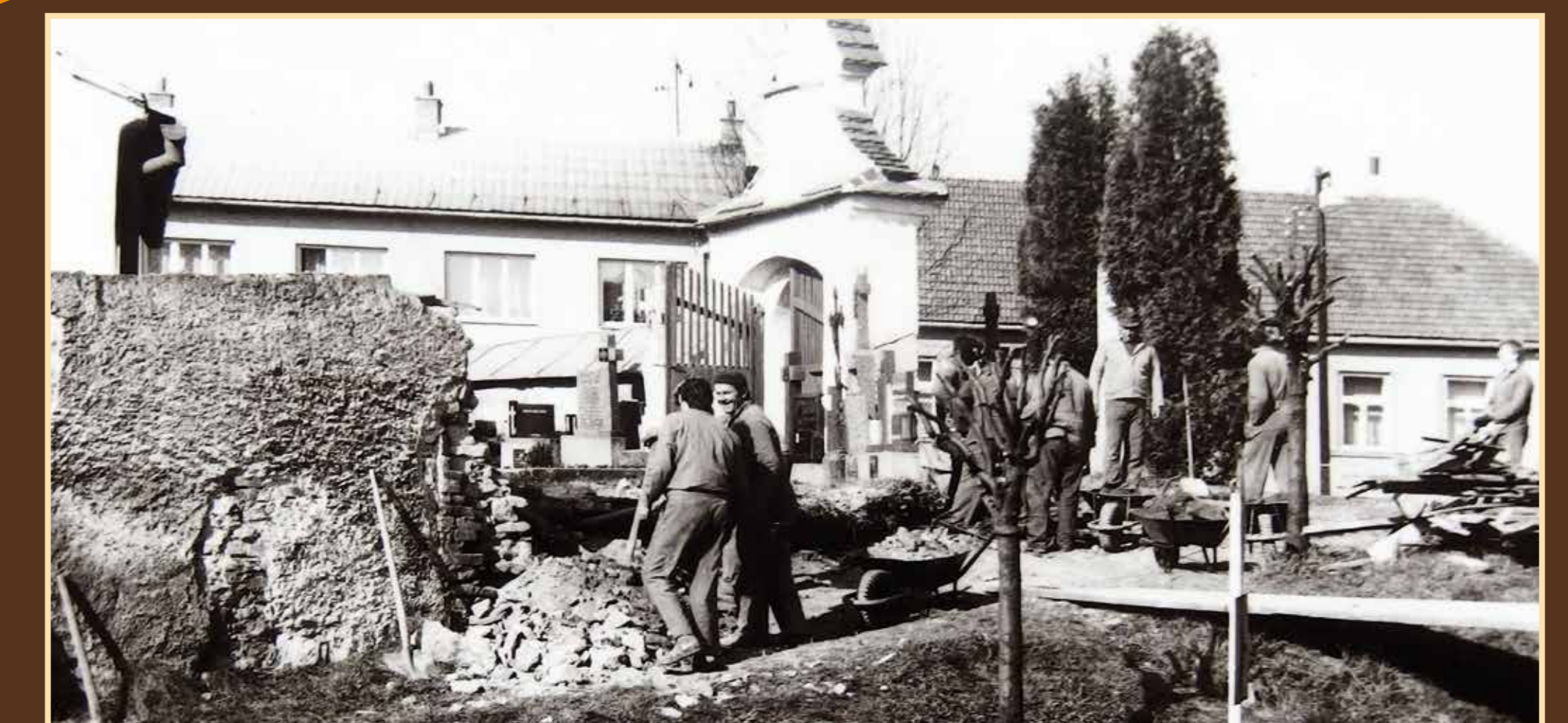
› Rekonstrukce hřbitovní zdi
