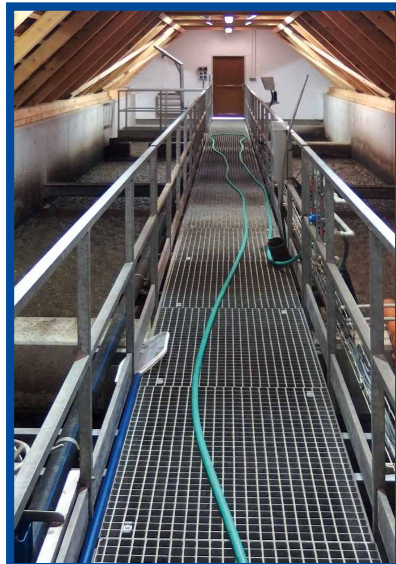
› Hala biologického čištění
