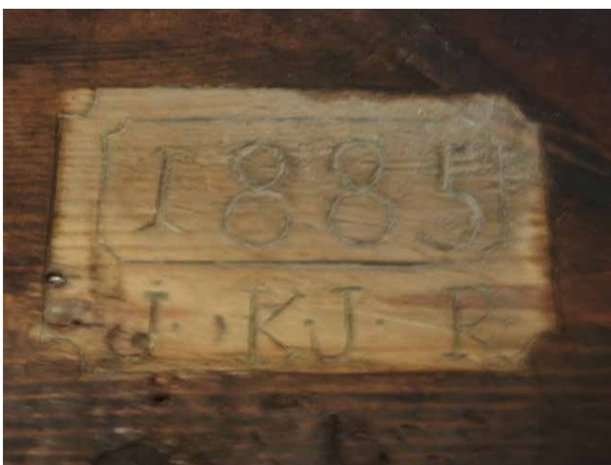
Rok obnovy mlýna po požáru na trámu ve mlýně
