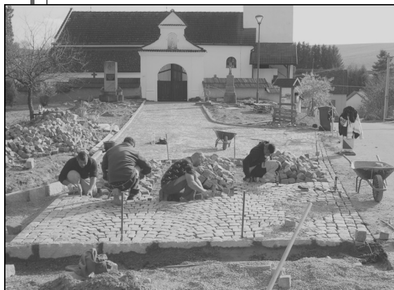
po přeložení původního chodníku.
