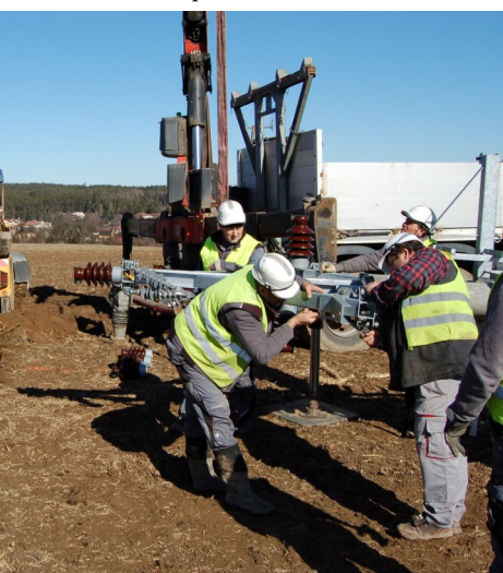
5. Beranidlo a lžice se dostaly k základům sloupu. Dokončuje se vystrojování nového sloupu.
