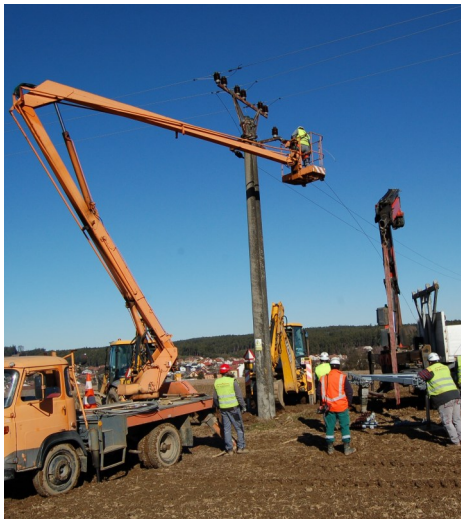
2. Plošina stoupá nahoru. Traktorbagry odstraňují zeminu a beton u sloupu. Začíná vystrojování nového sloupu.
