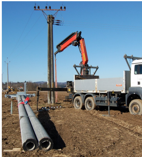
1. Na řadě je sloup, ze kterého vede odbočka až do transformátoru u školy.
