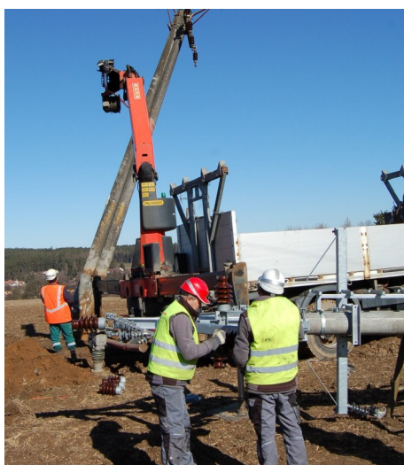
6. Jeřáb vyzvedl a pokládá starý sloup.
