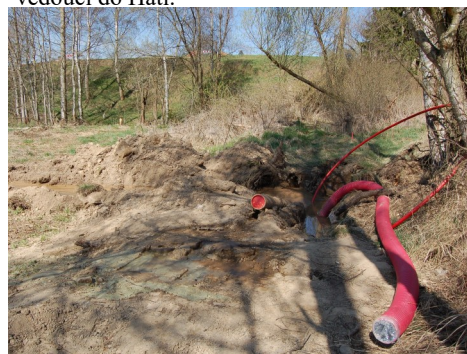
7. U vodní nádrže kabel vede obtížným terénem krajem lesa a přes potůček do svahu.
