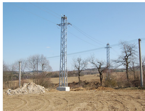
3. Nové stožáry převádí elektrické vedení u křížku na Oklíku přes silnici.
