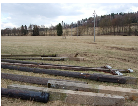
11. V tomto úseku byly dřevěné sloupy odstraňovány až po stavbě nového vedení.
