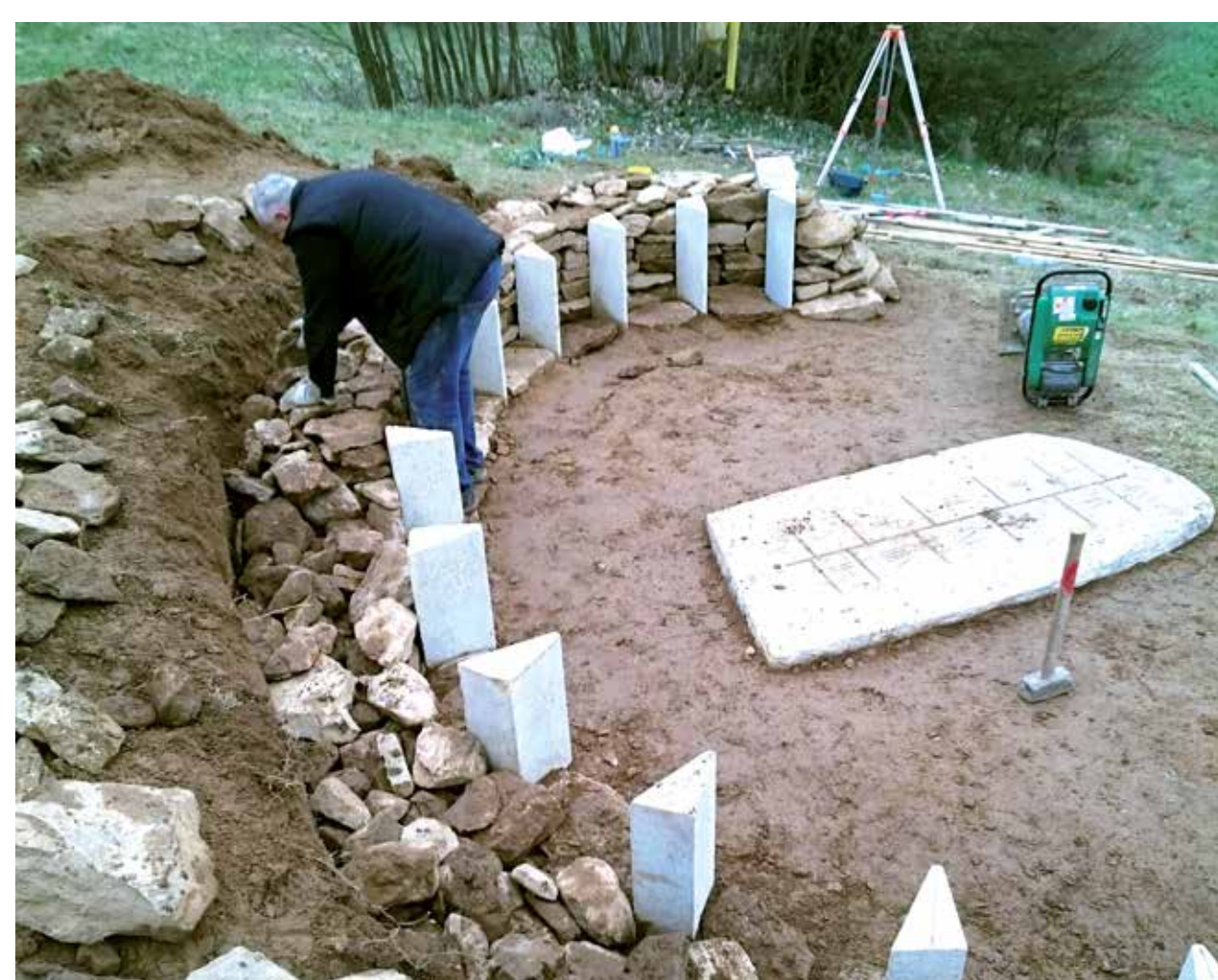
Rovnění opěrné zídky
