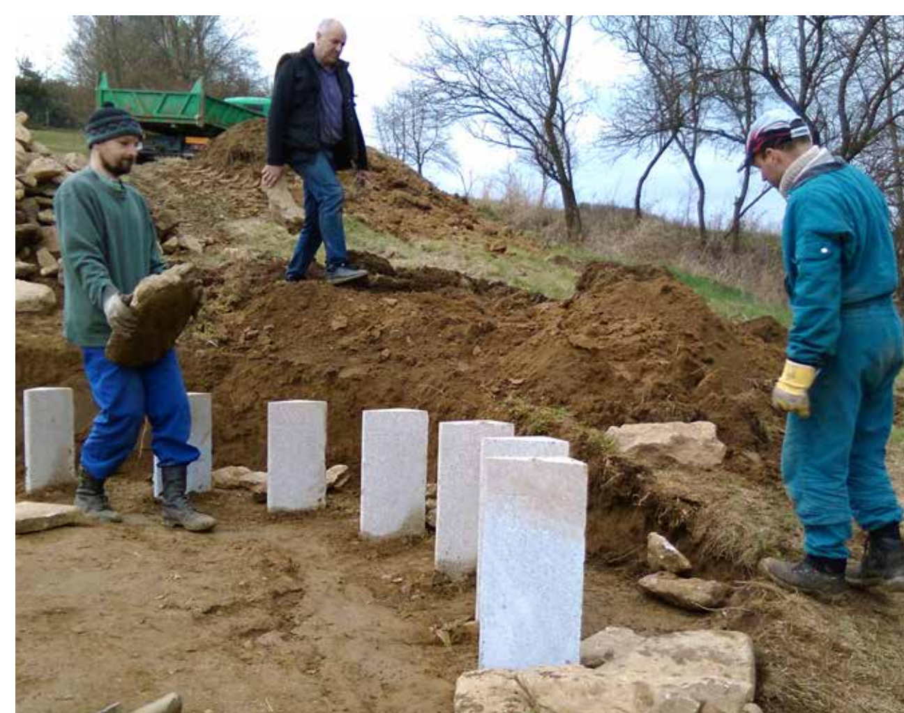
Rovnění opěrné zídky
