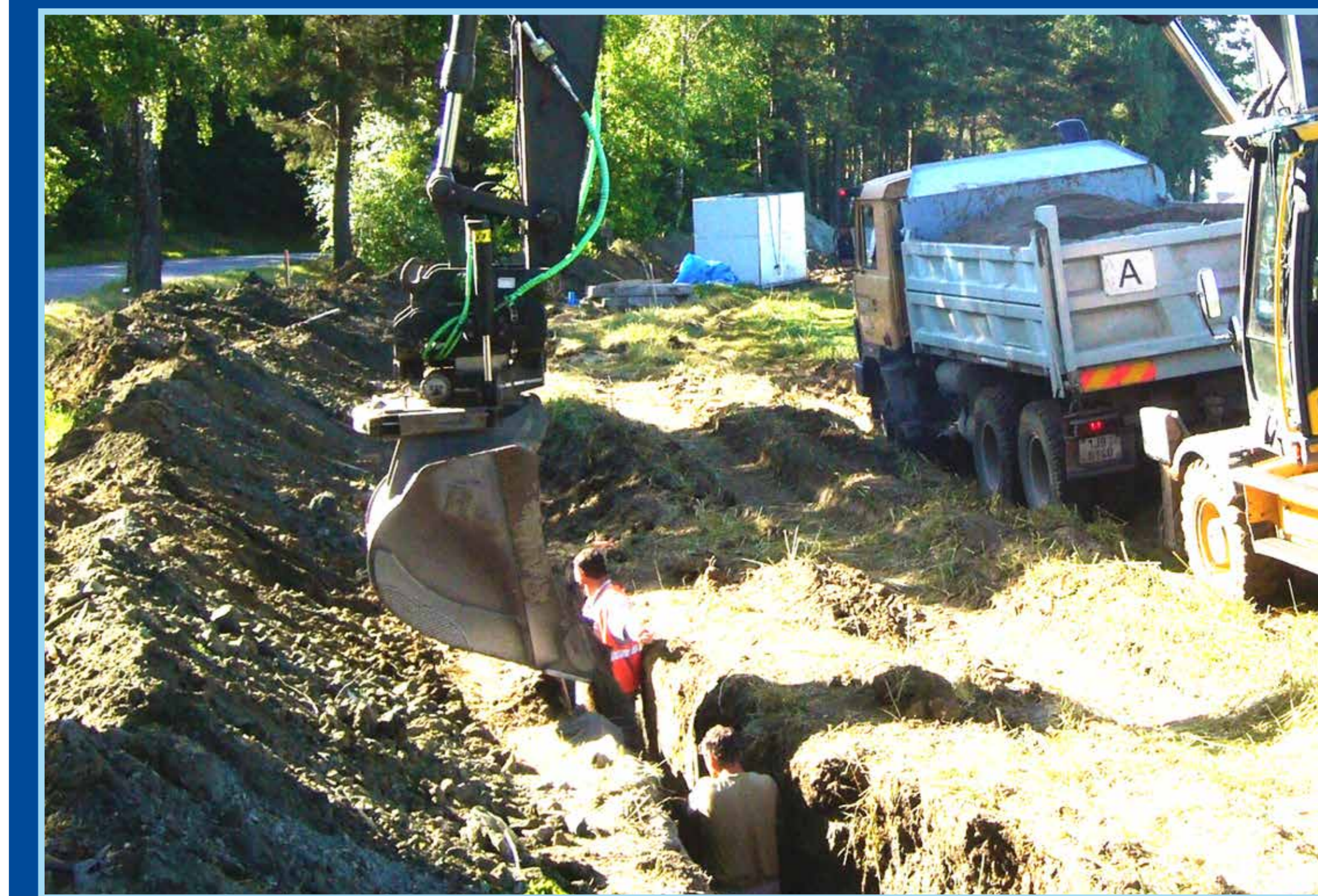
➤ Zасыпávání výkopů s potrubím
