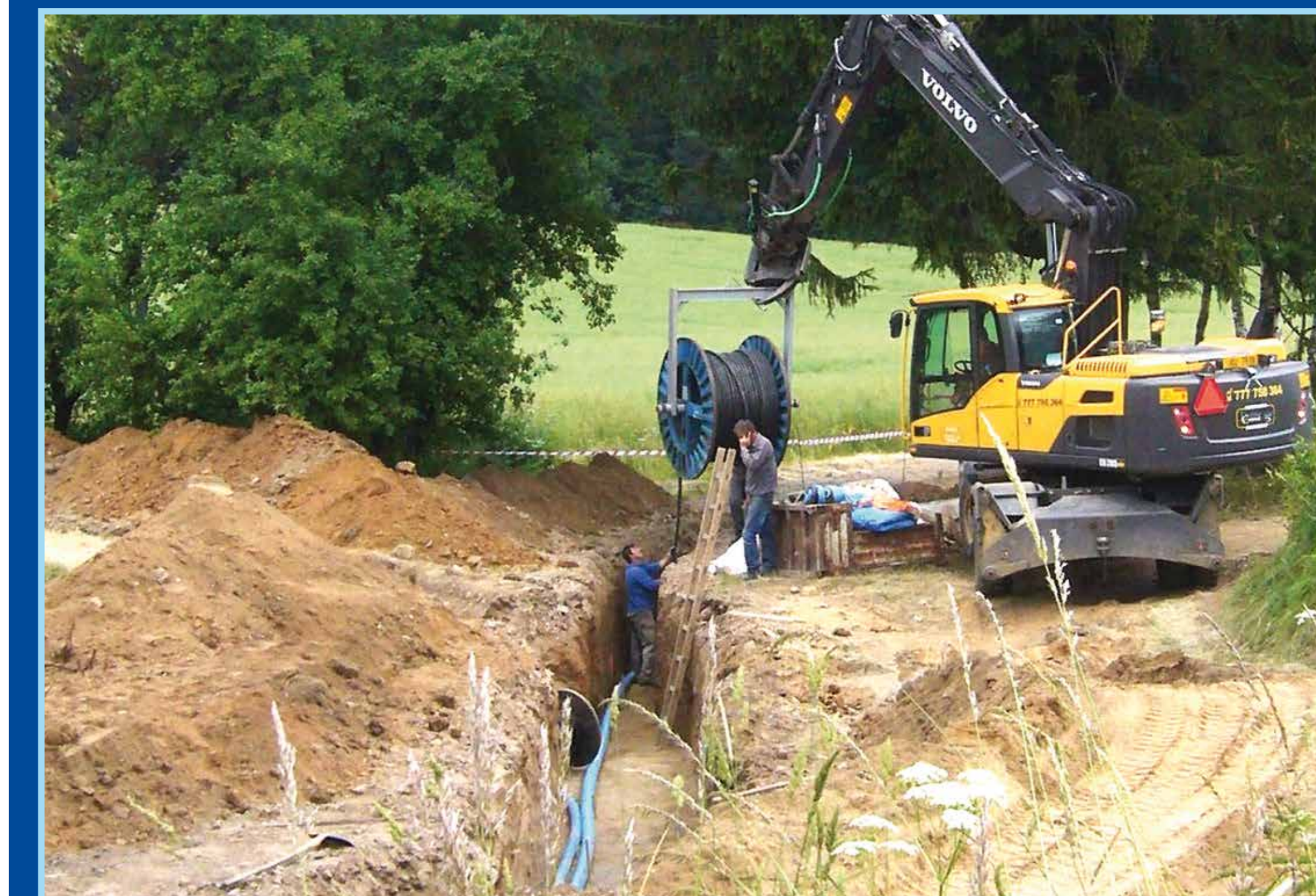
➤ Pokládání potrubí
